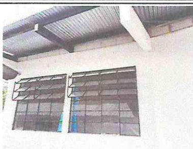
Foto 2: vidrio en ventanales de bodega y sellado en corona de paredes.
