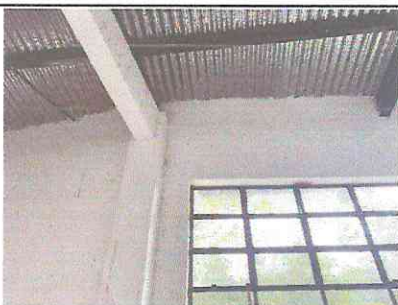
Foto 3: sellado en solera corona de bodega.
