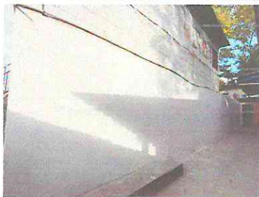
Foto 7: pared exterior de aula.
