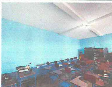
Foto 8: paredes interiores de aula.
