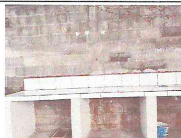
Foto 6: mesón de concreto con azulejo.
